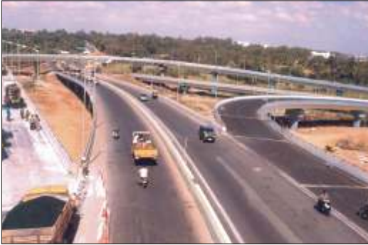
Hebbal Grade Separator
